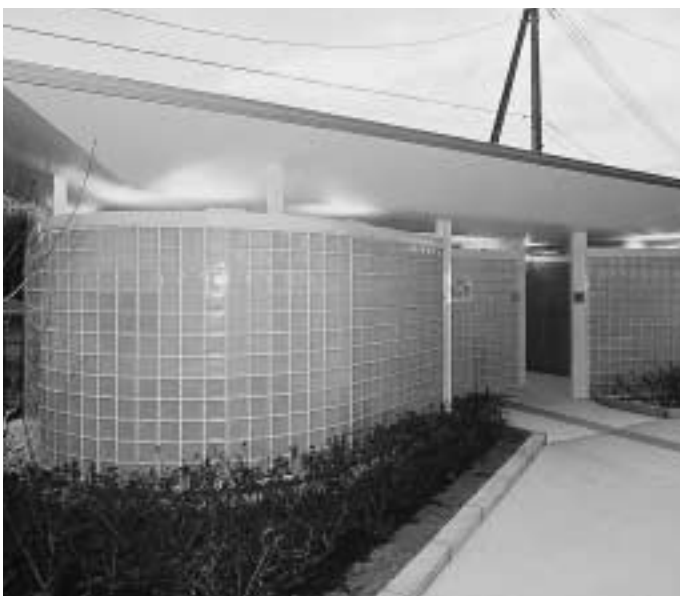
完成した志久駅前公衆トイレ
