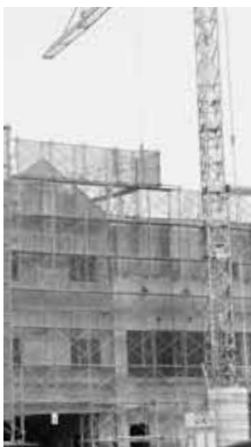
建設が進む(仮称)小針北小学校
