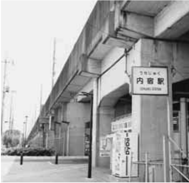
エレベーター等設置調査駅
