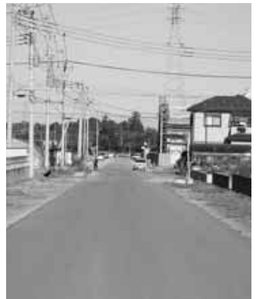
早期の整備が望まれているコミュニティ道路（右奥が建設中の（仮称）小針北小学校）
