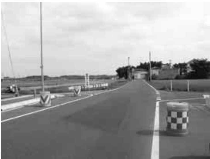
整備予定の東農免道(いな穂街道)
