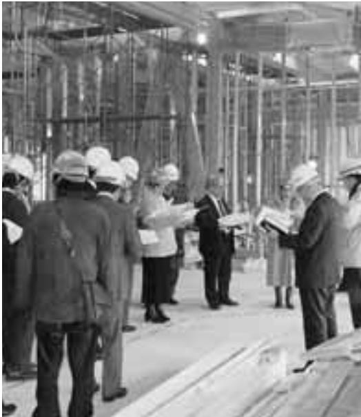
建設中の新北保育所を視察
