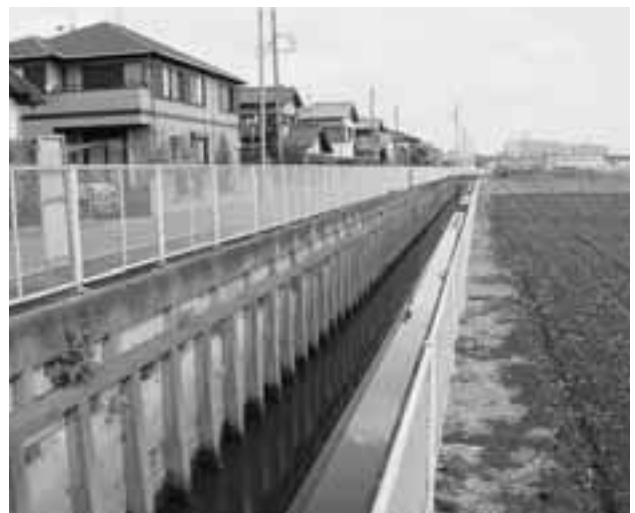
栄一丁目排水路
