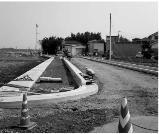
公共工事の現場（いな穂街道）
