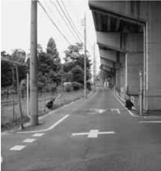
新幹線西側側道
