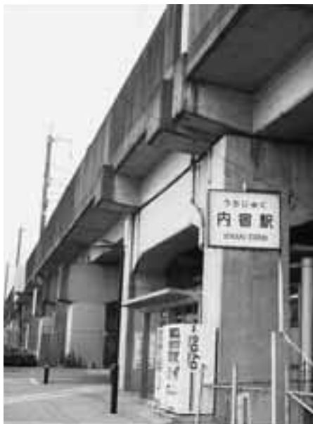
エレベーターの設置駅
