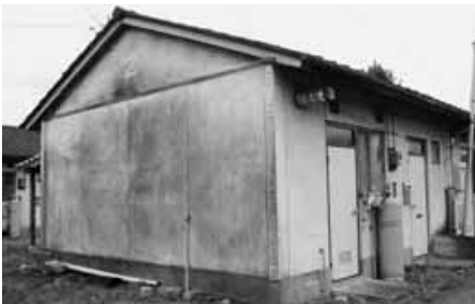
老朽化した町営住宅
