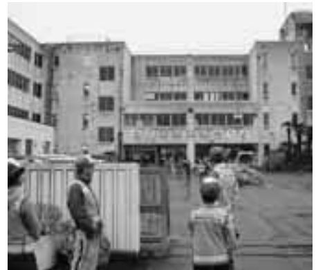
耐震補強が必要な南小学校
