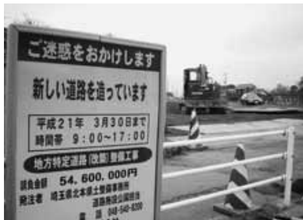
県道伊奈中央線第一期工事現場
