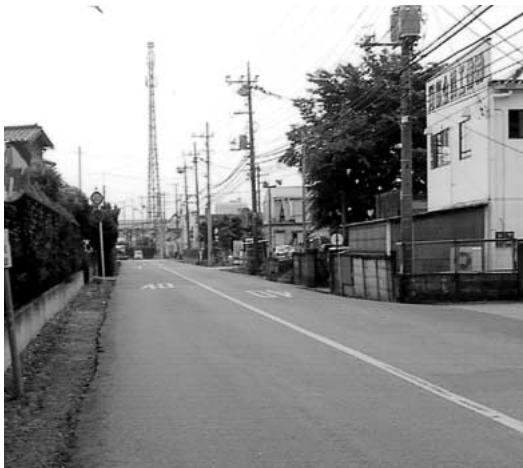
歩道の整備が望まれる(伊奈中央線)
