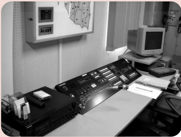
防災無線操作卓を交換
