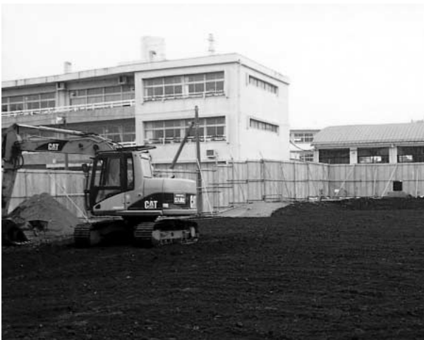
小針小学校体育館建設予定地
