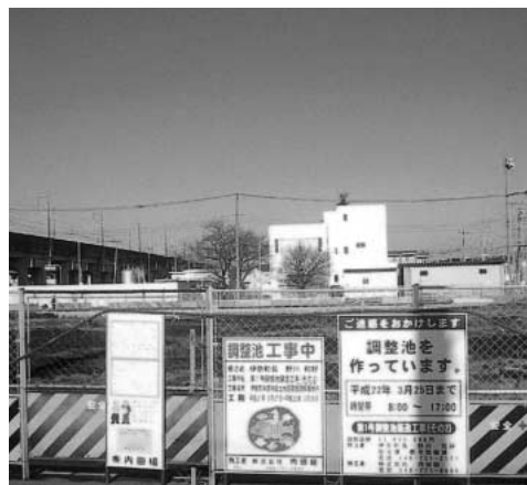
中部区画整理地内第一調整池
