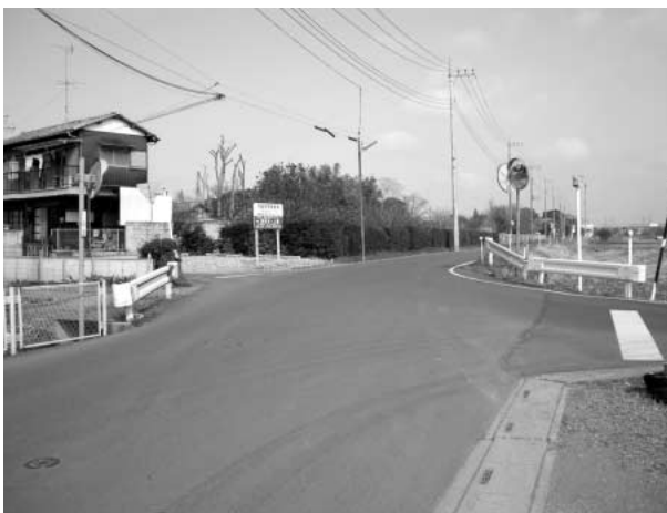
安全対策と改修工事が望まれる交差点
