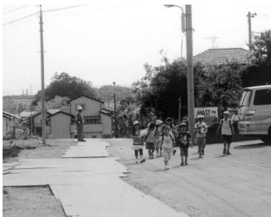
工事現場脇の通学路
