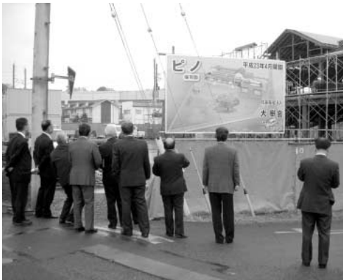
民間保育所建設現場を視察
