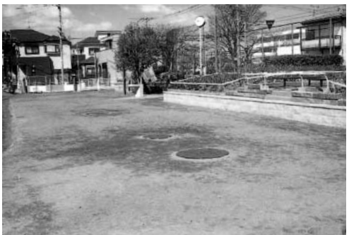
南部大公園 地下埋設された耐震性貯水槽
