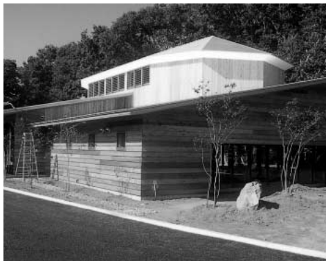
完成間近の介護施設
