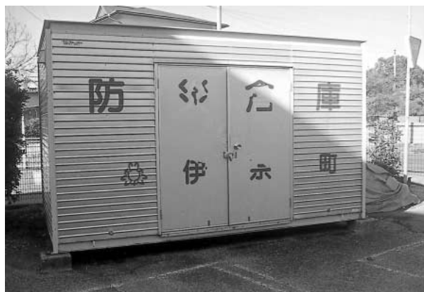
南小学校防災倉庫
