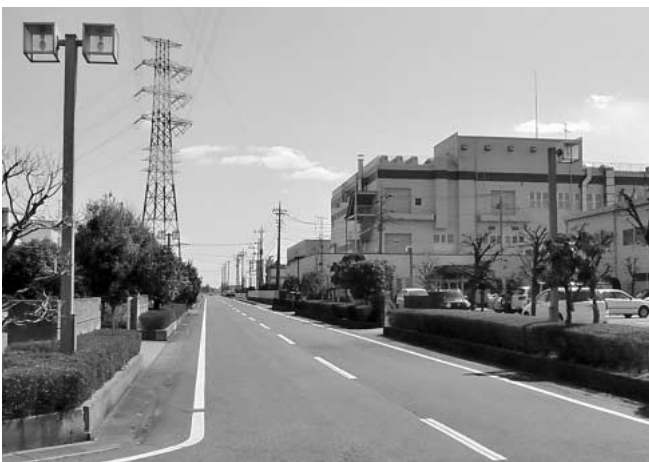
伊奈町工業団地内
