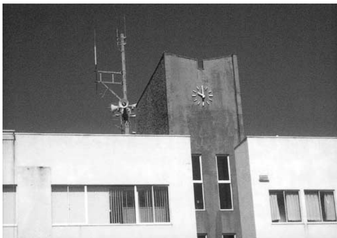
J-ALERTシステムを有した防災行政無線（役場）
