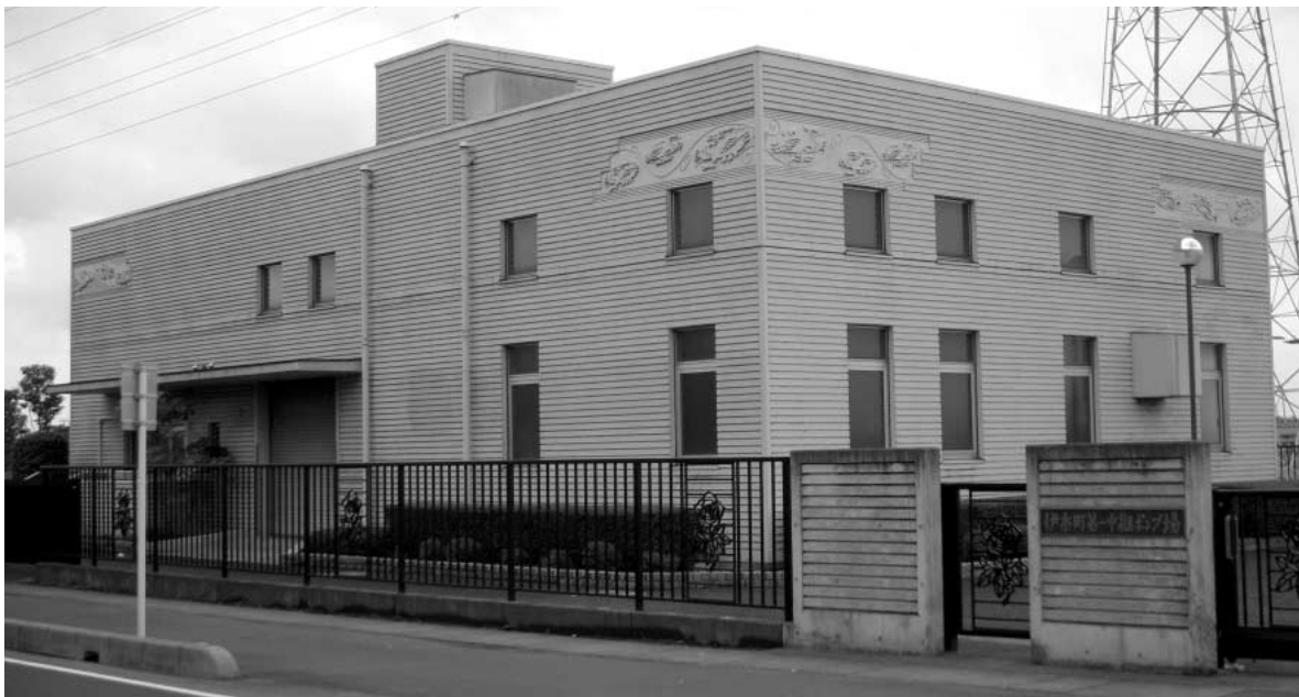
第一中継ポンプ場
