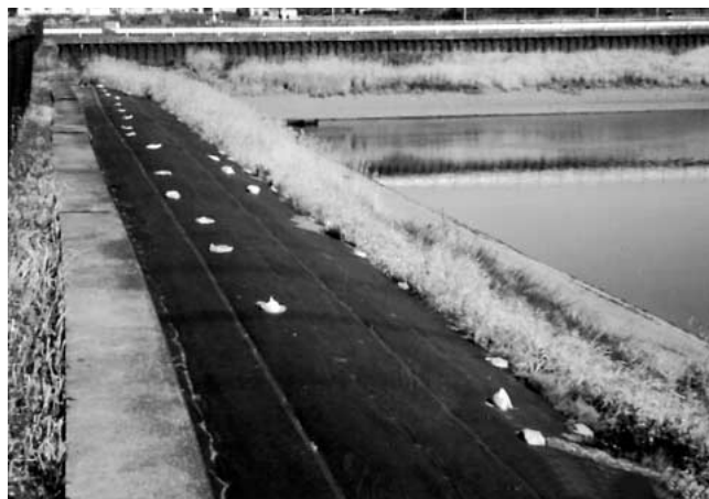
伊奈学園西側第一調整池法面(斜面)
