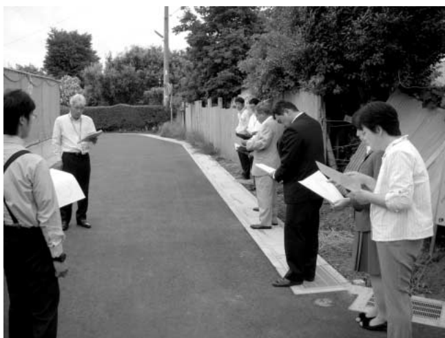
町道認定道路を視察
