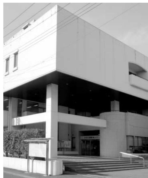
総合センターの耐震工事が始まります
