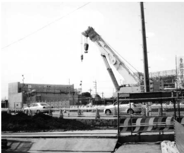
工事中の圏央道
