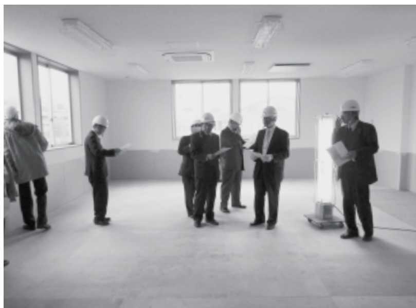
新小針北児童クラブ建設工事現場を視察
