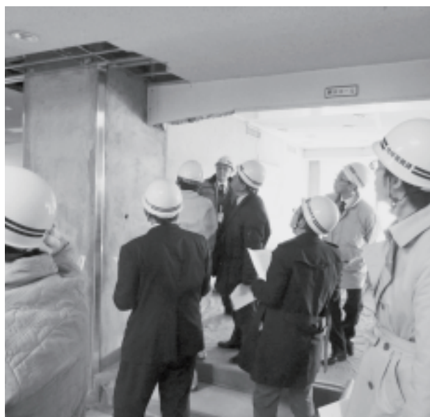
総合センター耐震工事施工状況を確認
