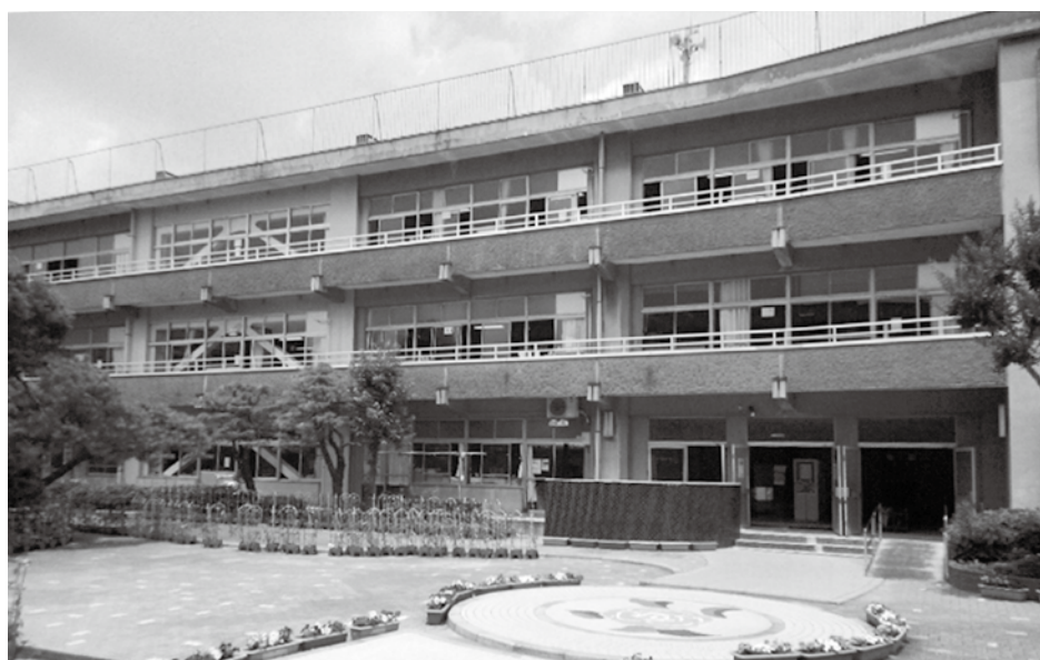
改修が待たれる小室小学校北校舎
