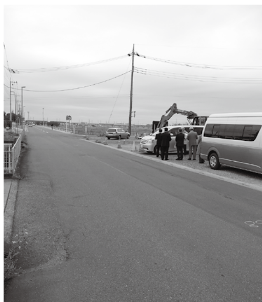
栄六丁目地内いな穂街道歩道整備工事現場
