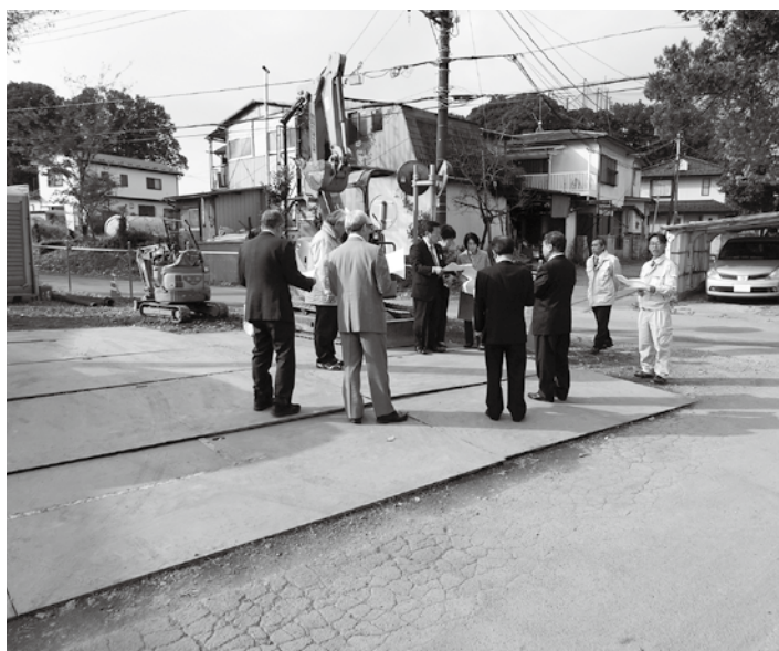
小針新宿地内道路拡幅改良工事現場
