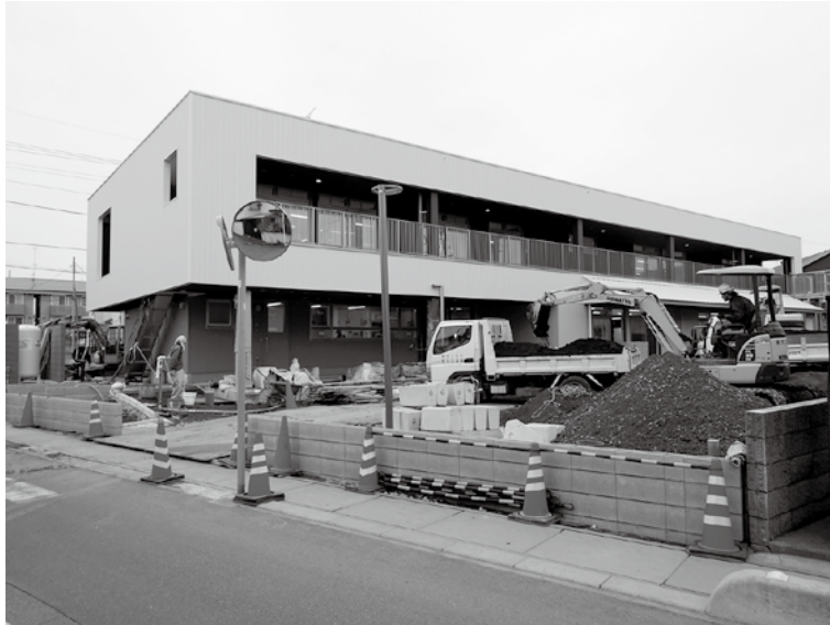
きむら伊奈保育園を建設中です
