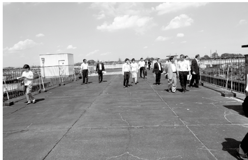
小室小学校南校舎の屋上を視察しました
