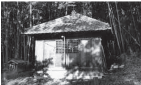
作業前 (2013.11.6撮,写真提供 丸の内住民より)
