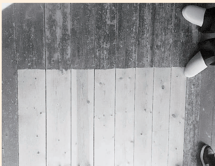
北保育所の床 白い部分が補修後の仕上がり状態
