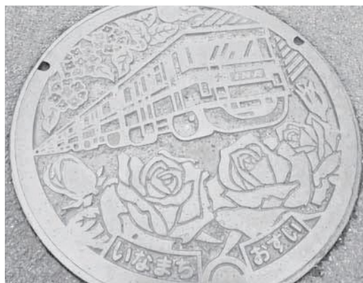
ふた 下水道マンホールの蓋
