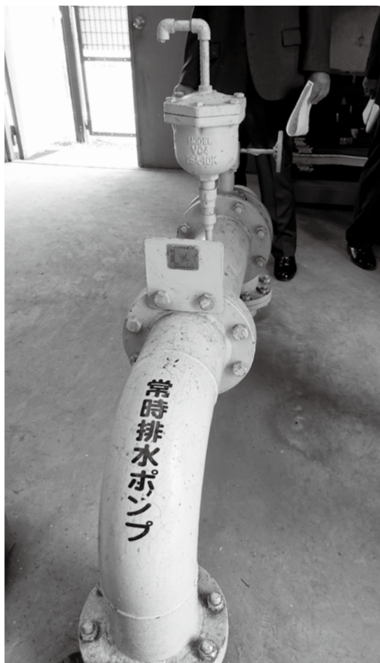
交換修繕を行う、第一調整池排水機場の常時排水ポンプ
