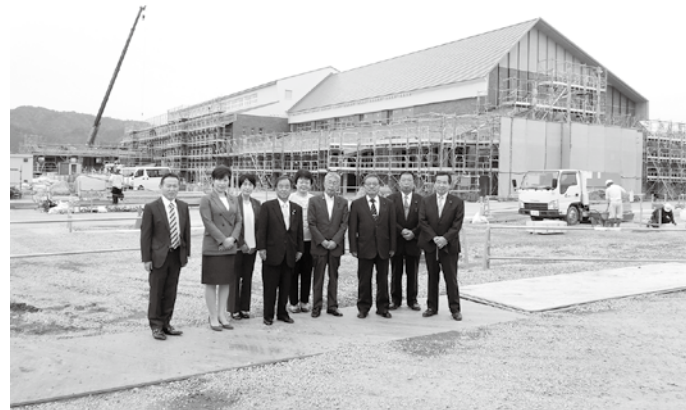
会津美里町新庁舎（複合施設）現場建設中
