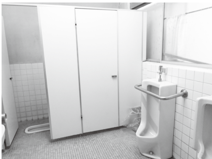
便器の洋式化だけでなく、床も壁もリニューアルします
