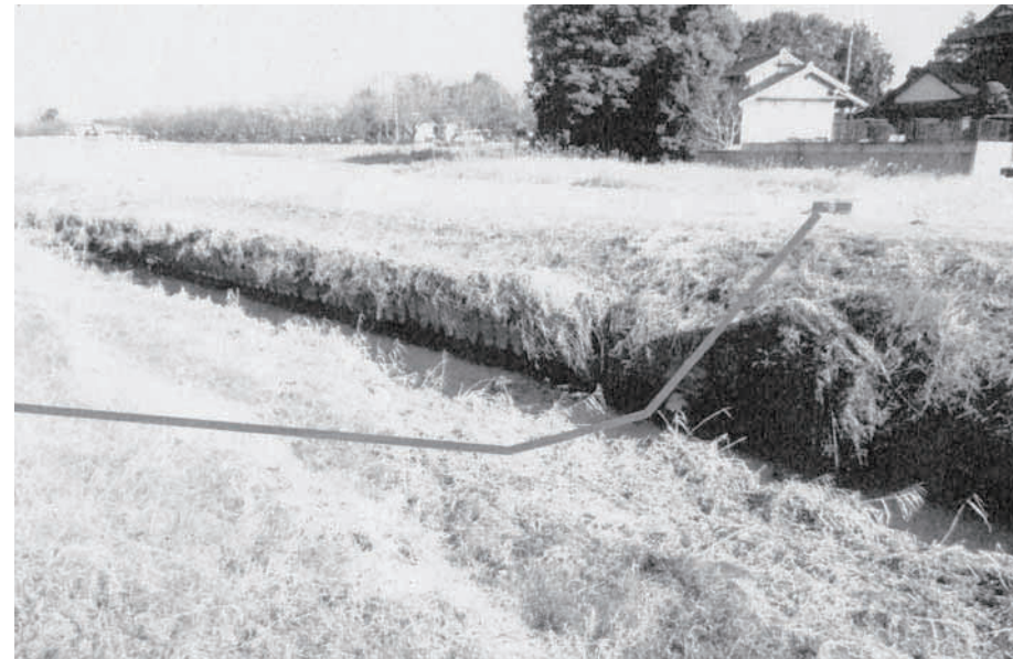
線で示した場所の地下にある配管の付け替え工事です
