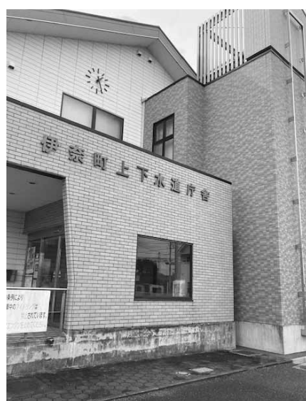
水道基本料金を6か月間無料にした(上下水道庁舎)
