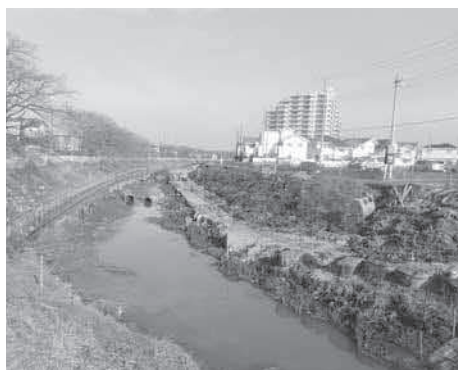
伊奈町エリアの綾瀬川は、大々的にしゅんせつ工事が行われました
