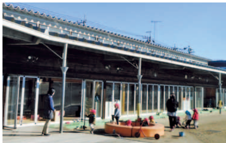
ICTシステムが導入される北保育所
