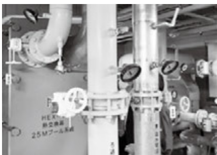
余熱を利用し、プールを温水にする「熱交換器」の装置
