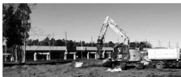
整地中の建設現場
