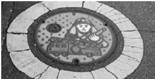
消火栓は黄色くふちどりされています
