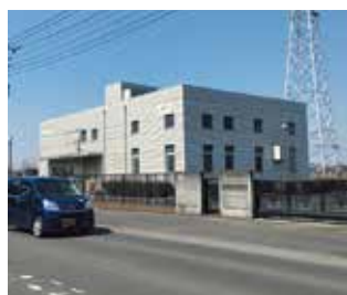
伊奈町第一中継ポンプ場
