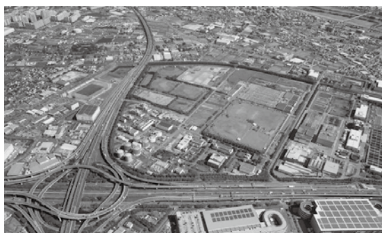
三郷市にある大規模下水道処理施設（県HP）。大規模インフラの老朽化がもたらす危険・影響の甚大さが明らかに
