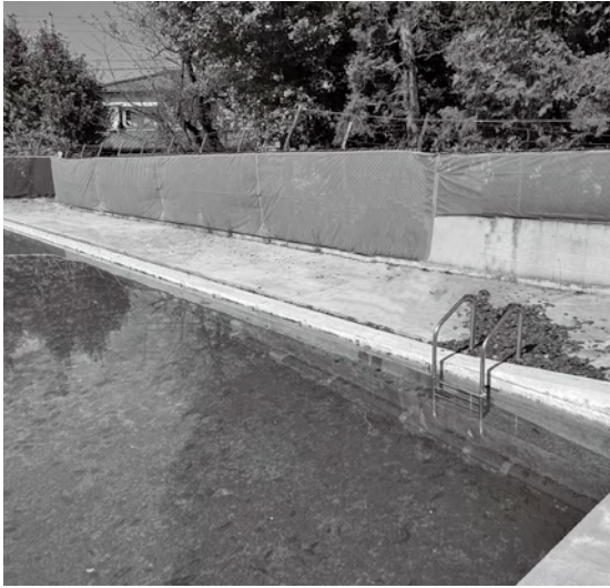
設置後50年以上経過する伊奈中学校のプール
