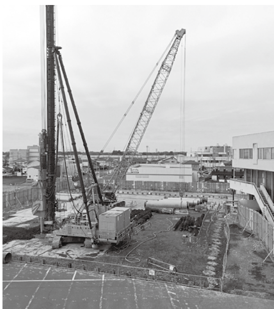
本格的に開始した庁舎建設工事
