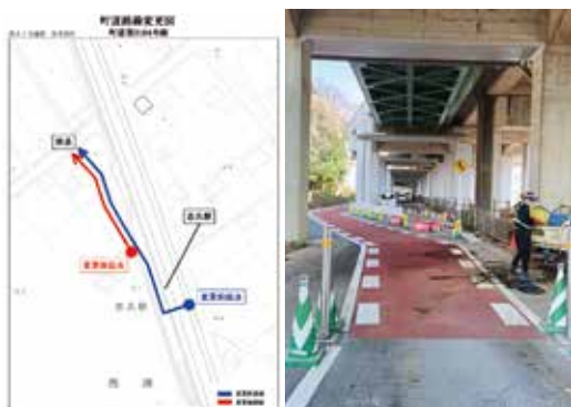
志久駅エレベーター設置に伴い、町道路線が変更
