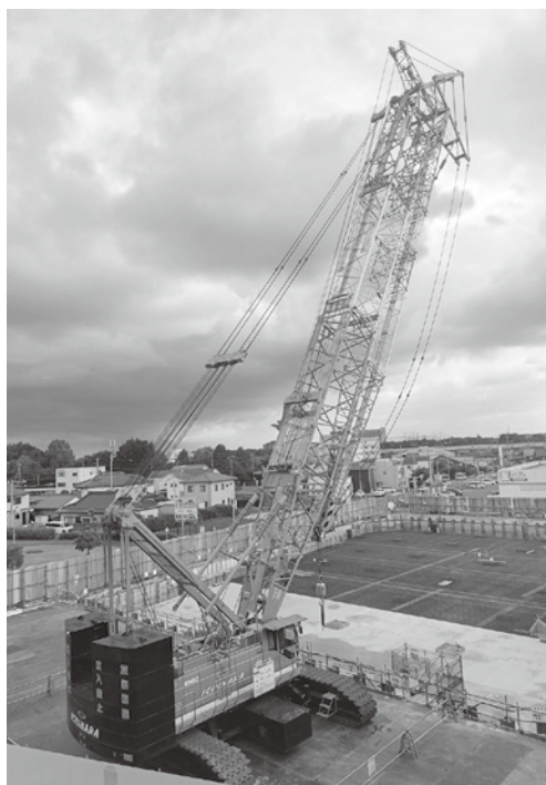
組み立てられた大型クローラー（キャタピラ）クレーン。写真はクレーンを2つに重ねていますが、最高到達点は約65mです
